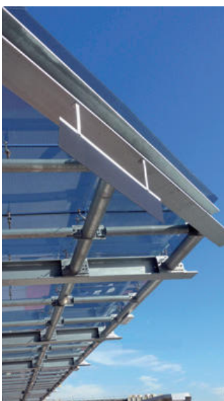
Lasirakenne Vigon lentokentällä Espanjassa, kasinon sisäntulo Zaragotsssa ja kauppakeskuksen ilmastointijärjestelmän katto Marinedassa. Lasit kiinnitetty tyypihyväksytyillä PS pistekiinnitysheloilla.
