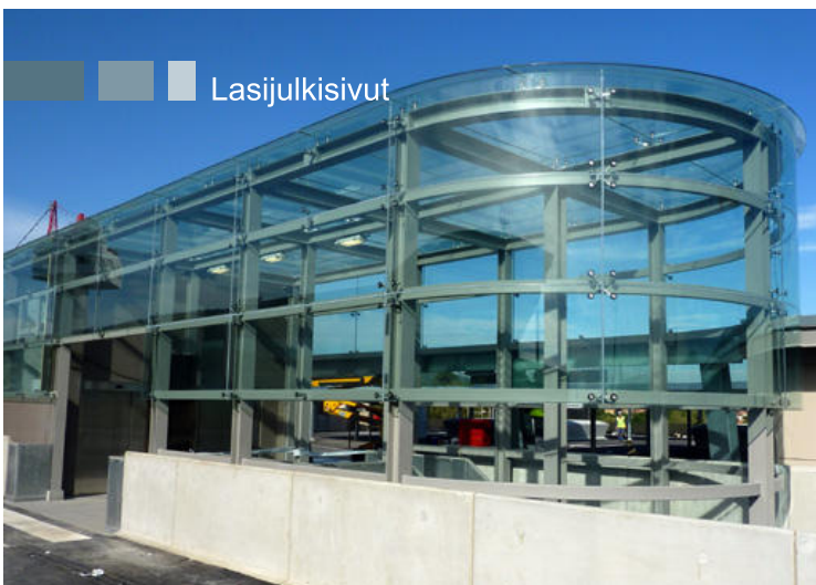
Lasirakenne Vigon lentokentällä Espanjassa, kasinon sisäntulo Zaragotsssa ja kauppakeskuksen ilmastointijärjestelmän katto Marinedassa. Lasit kiinnitetty tyypihyväksytyillä PS pistekiinnitysheloilla.
